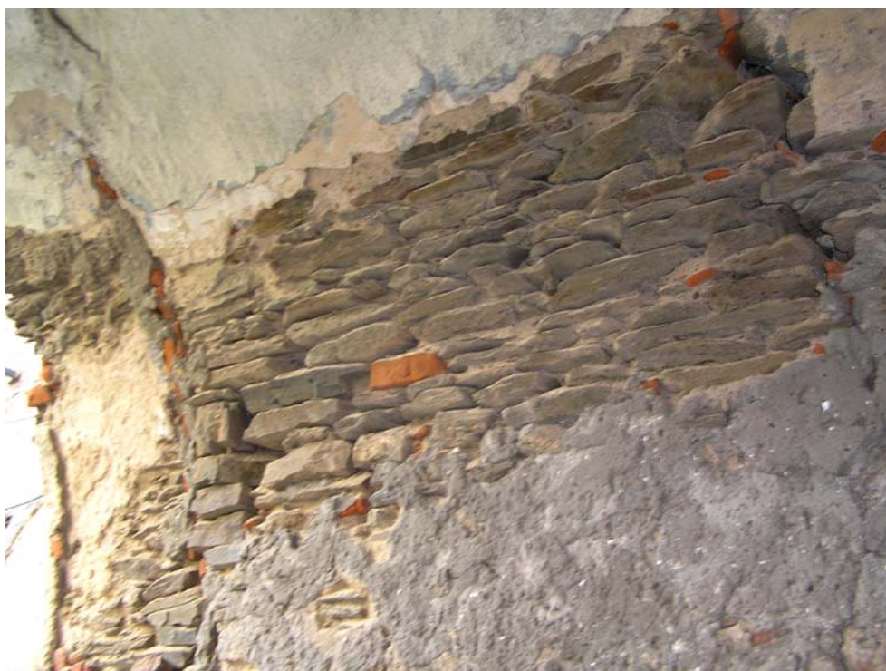
Foto 2: Přizemí, detail trhlín ve stěně a klenbě průchodu na východní straně
