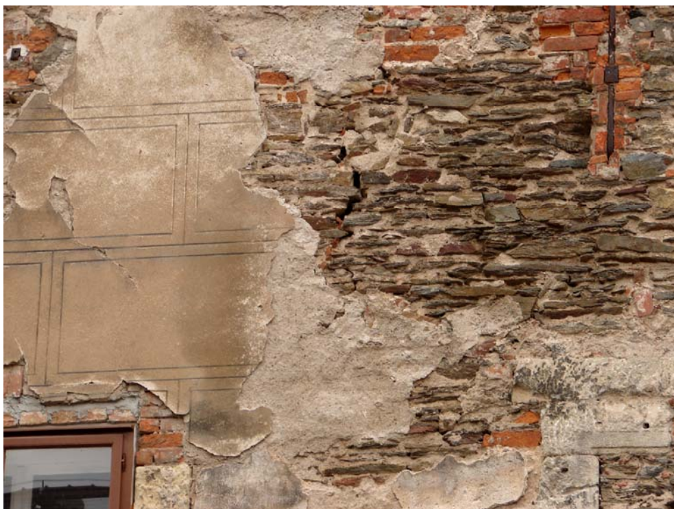
Foto 5: 1. patro, svislá trhlina v západní stěně
