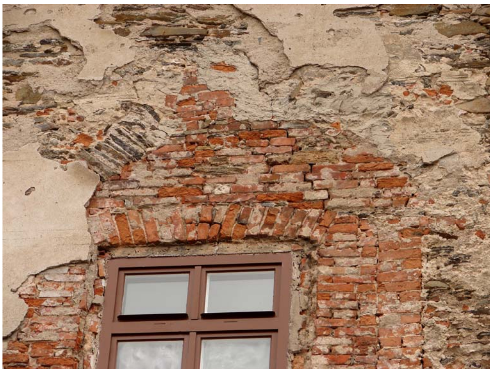
Foto 7: 2. patro, trhliny v západní stěně v oblasti nadpraží okna
