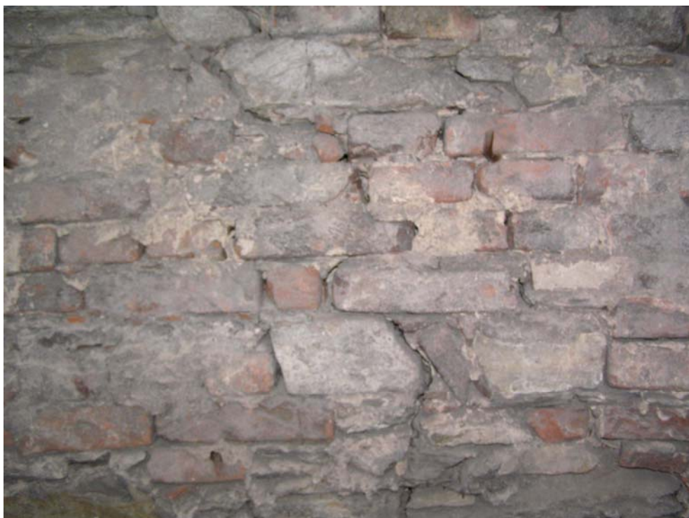
Foto 18: Krov, detail trhliny v jižní stěně
