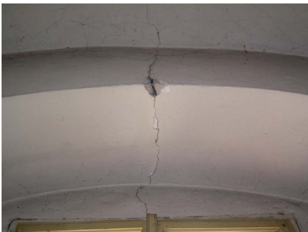
Foto 10: 2. patro, trhlina v nadpraží okna, východní stěna
