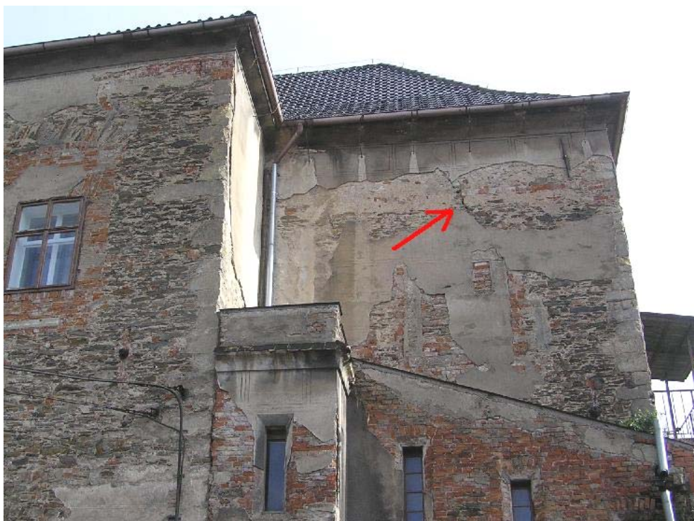
Foto 12: 2. patro, šikmá trhlina v západní stěně
