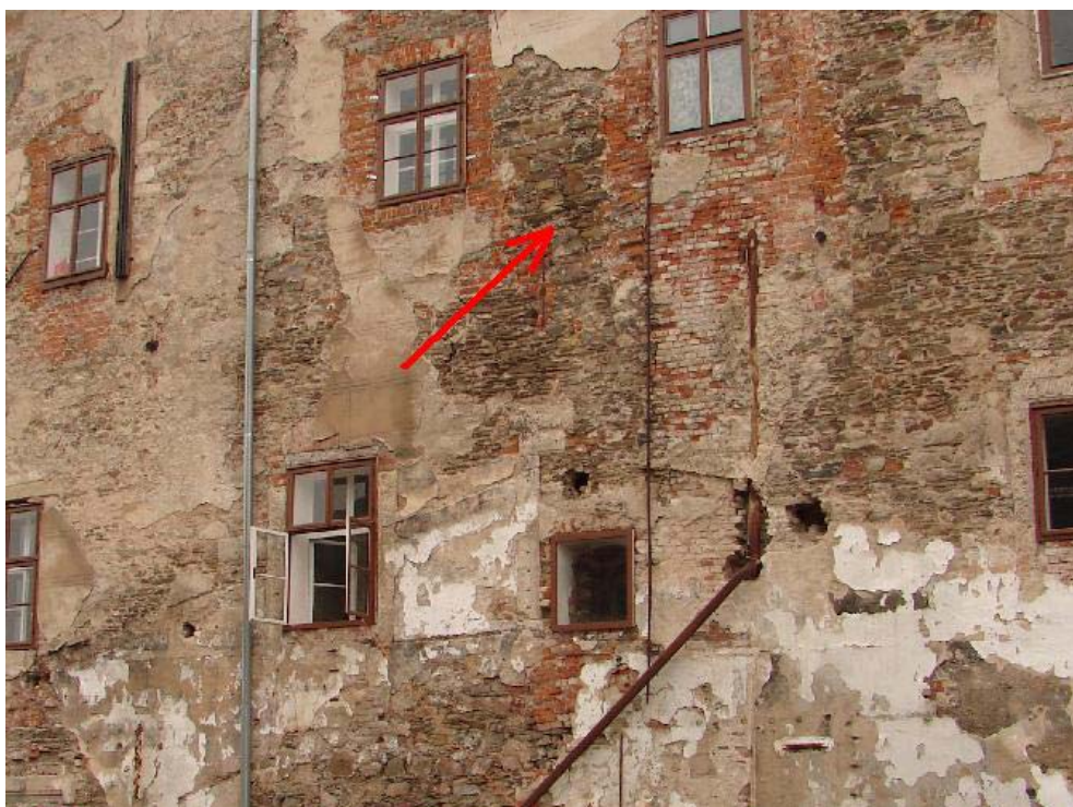
Foto 8: 2. patro, trhлина v západní stěně v úrovni parapetu oken
