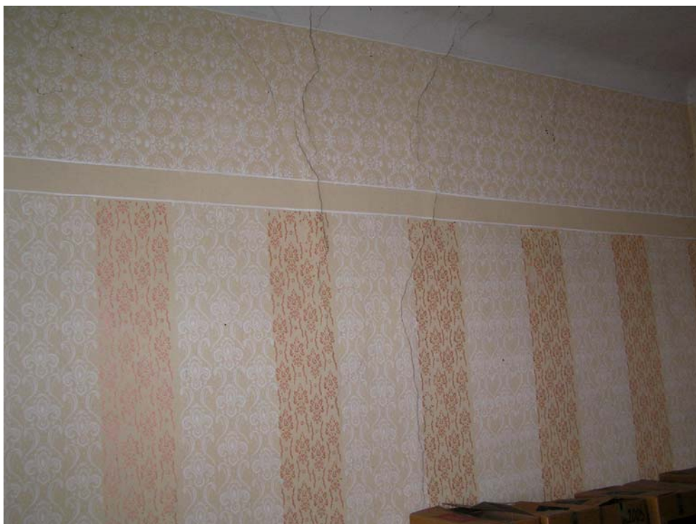
Foto 11: 2. patro, svislé trhliny ve vnitřní příčné stěně
