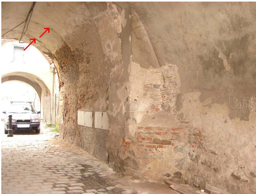
Foto 1: Přizemí, trhliny ve stěně a klenbě průchodu na východní straně
