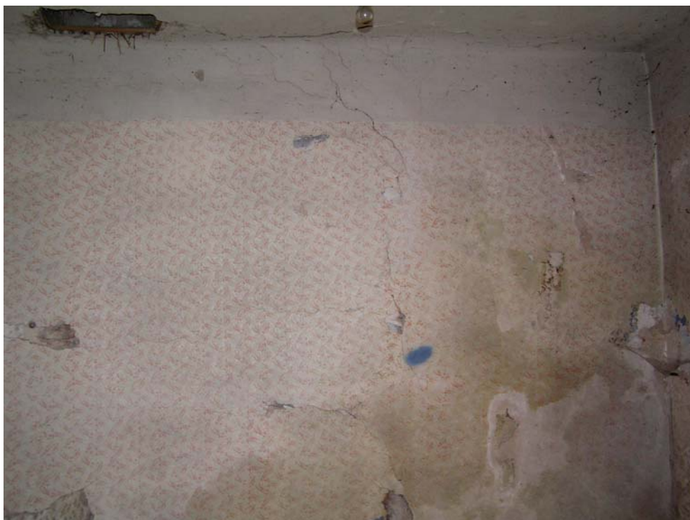
Foto 4: 1. patro, svislá trhlinka v západní stěně
