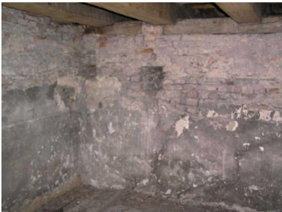
Foto 16: Krov, šikmé trhliny v západní stěně
