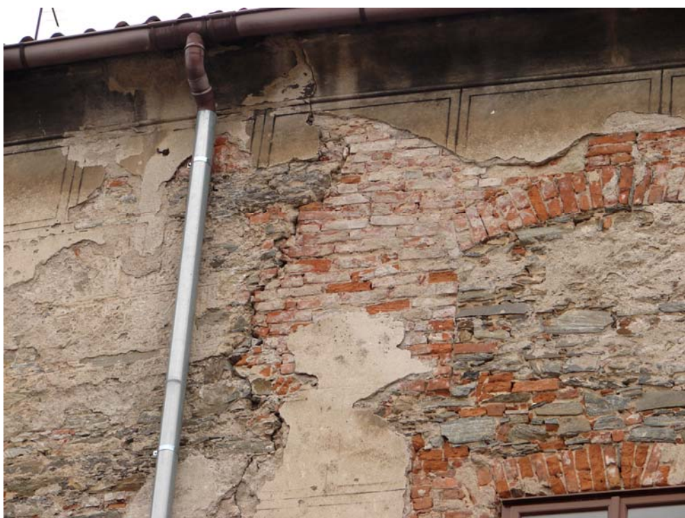
Foto 6: 2. patro, svislá trhlina v západní stěně
