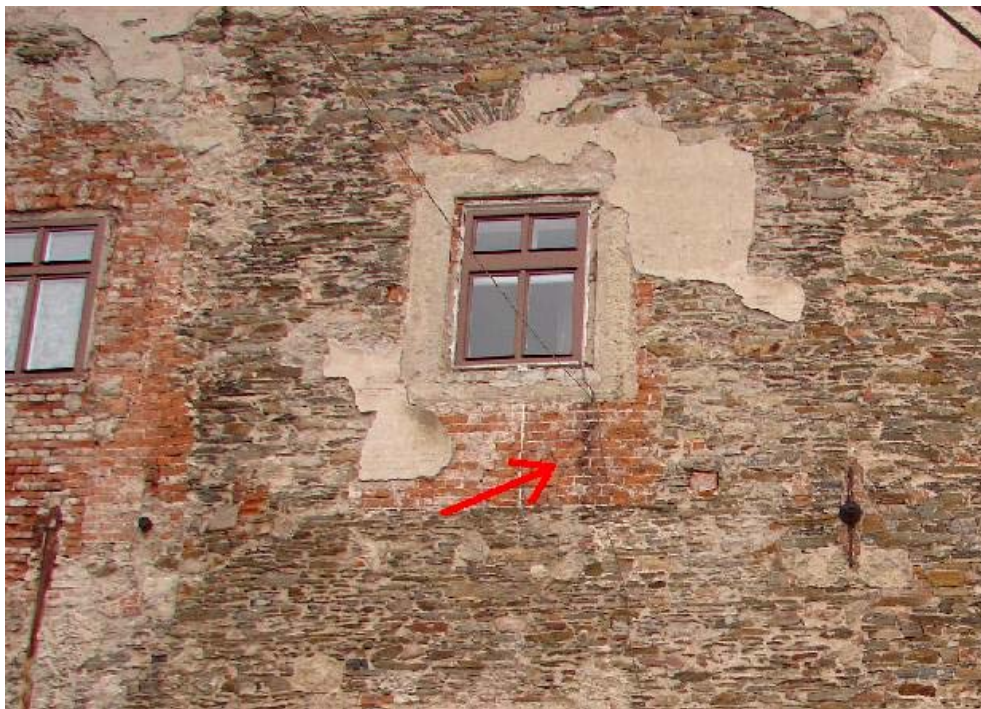
Foto 9: 2. patro, trhlina v západní stěně v parapetu okna
